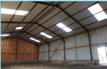
Notre hangar est mis **hors d'eau**, le gros oeuvre est terminé : cloisons et toiture ont été posées.
