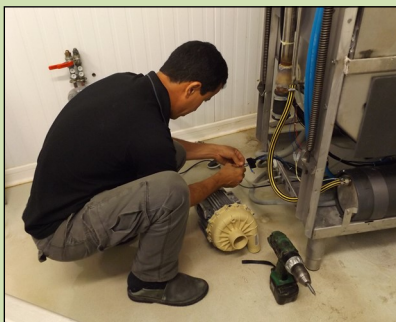
Remplacement du carter de la pompe de la « plonge » de la Conserverie
