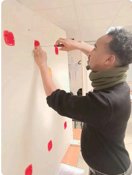
Saed pose des boîtiers électriques.
