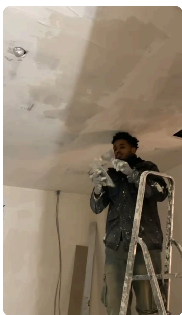
Abdi Shakur pose de l'enduit.
