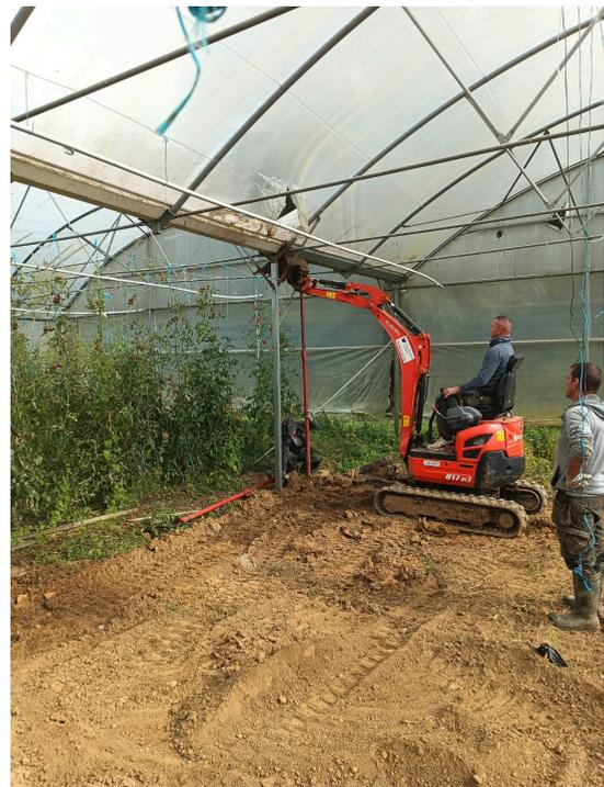
Une fois les bâches abimées déposées, les poteaux tordus changés et les chéneaux remis droits, on peut procéder à la pose des nouvelles bâches.
